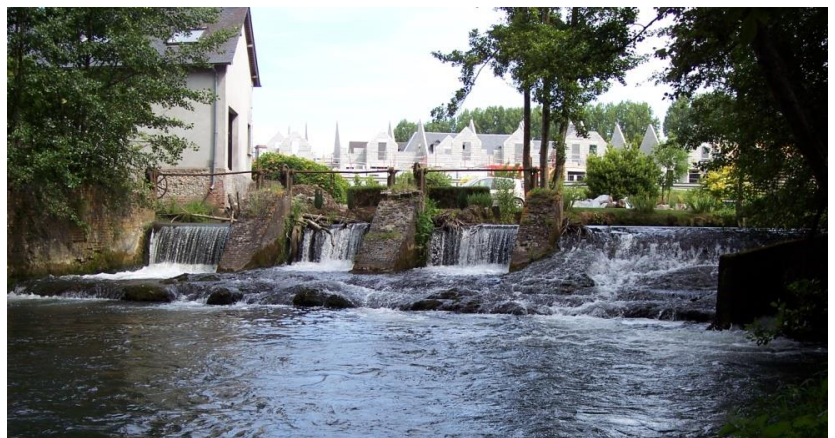
Figure 11 : Vannage de Sainte-Mélaine à Pont l'Evêque
