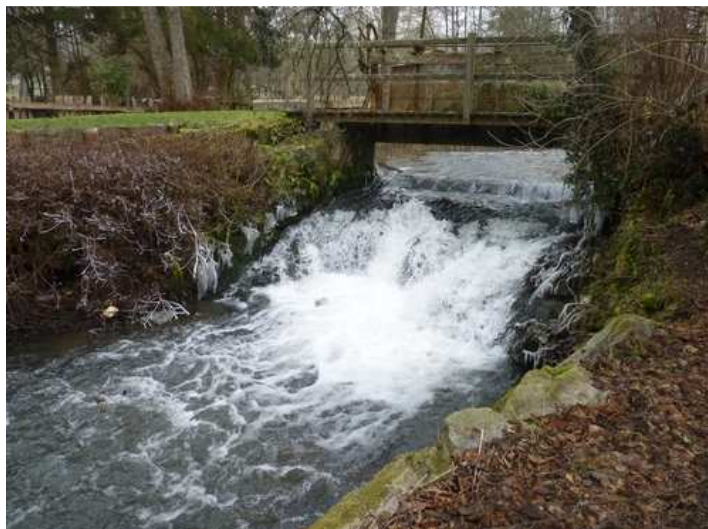
Figure 16 : Barrage de la Scierie à Bonneville-la Louvet (Barrage n°4)
